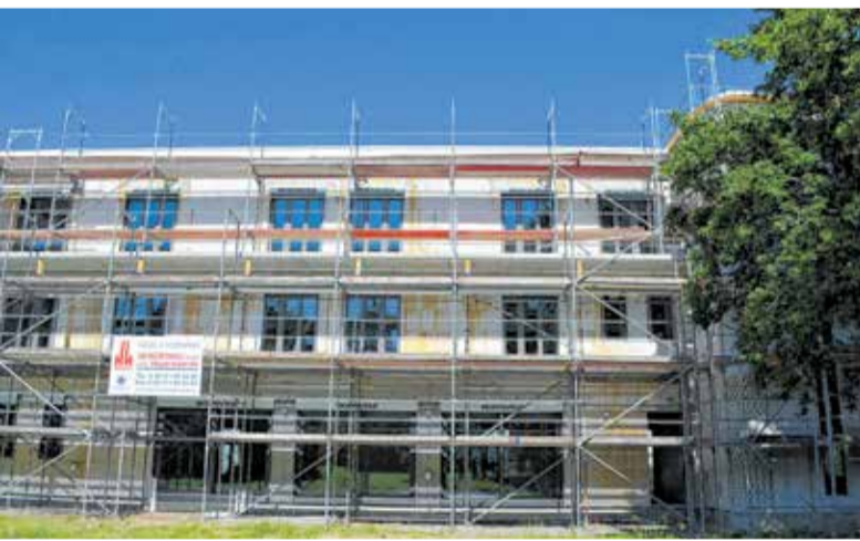
Im Neubau hat der Innenausbau bereits begonnen. Die Bauleute sind auf einem guten Weg.
