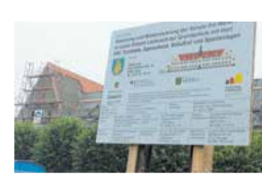
Die Sanierung der Schule am Laubuscher Markt soll Mitte 2021 beendet sein. Foto: skl
