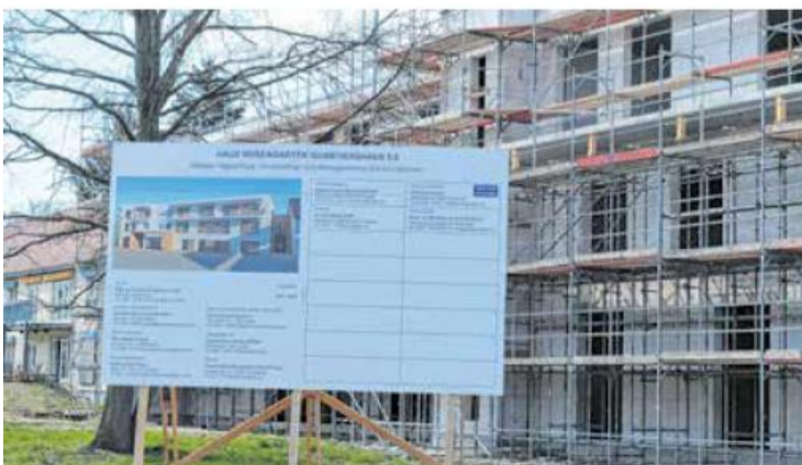
Im Bau: Am Haus Rosengarten entsteht zurzeit ein Erweiterungsbau. Das Richtfest ist der Corona-Krise zum Opfer gefallen.
